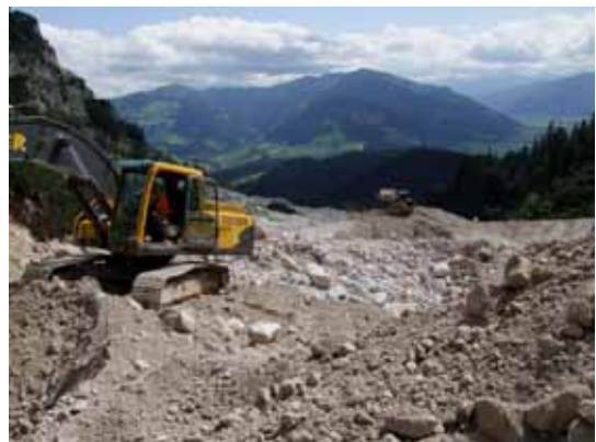
Räumungsgeräte im Einsatz
