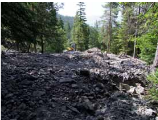
Zufahrt zum Parkplatz
